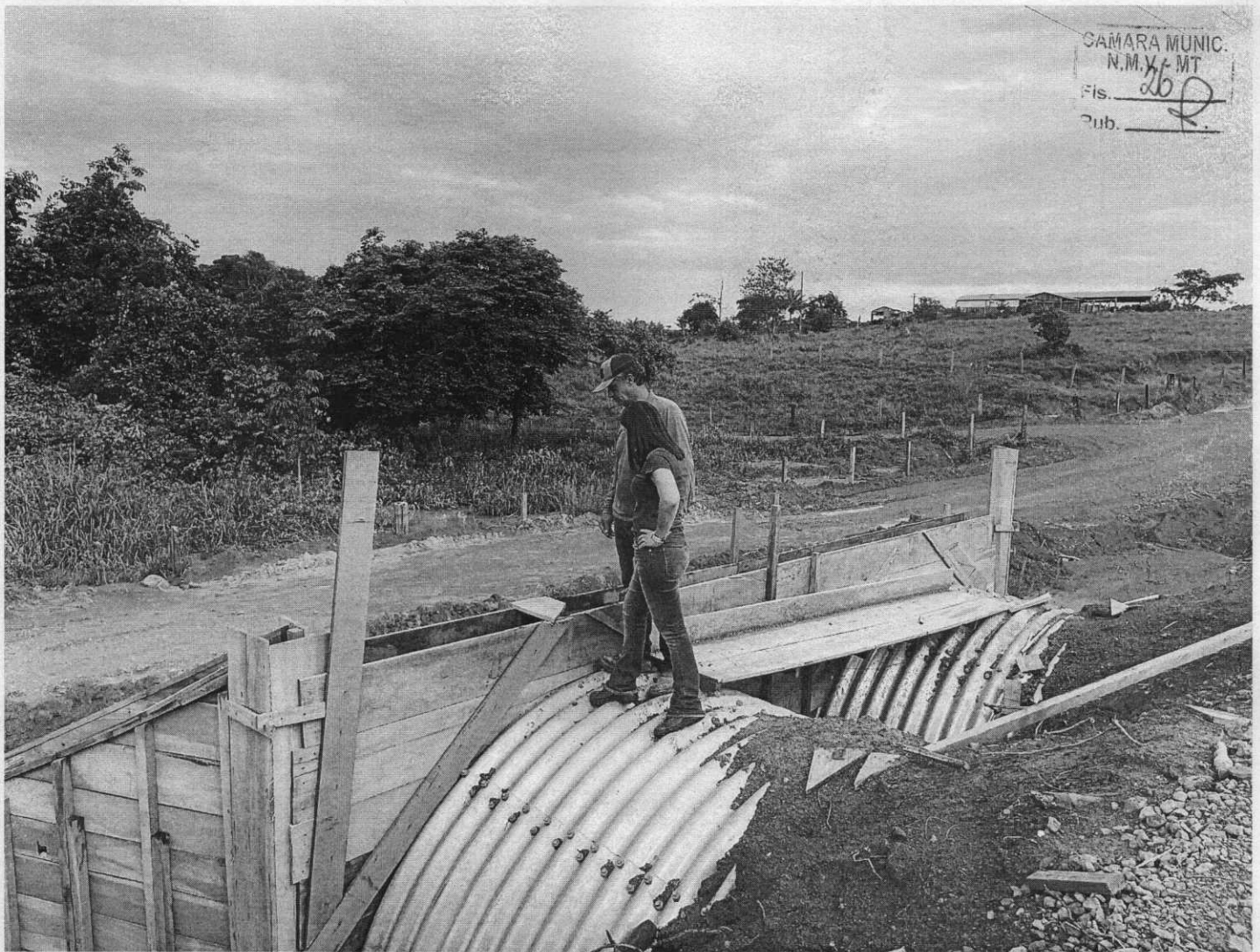
Visita na ponte e estrada Karobis - 09/10/2025.
